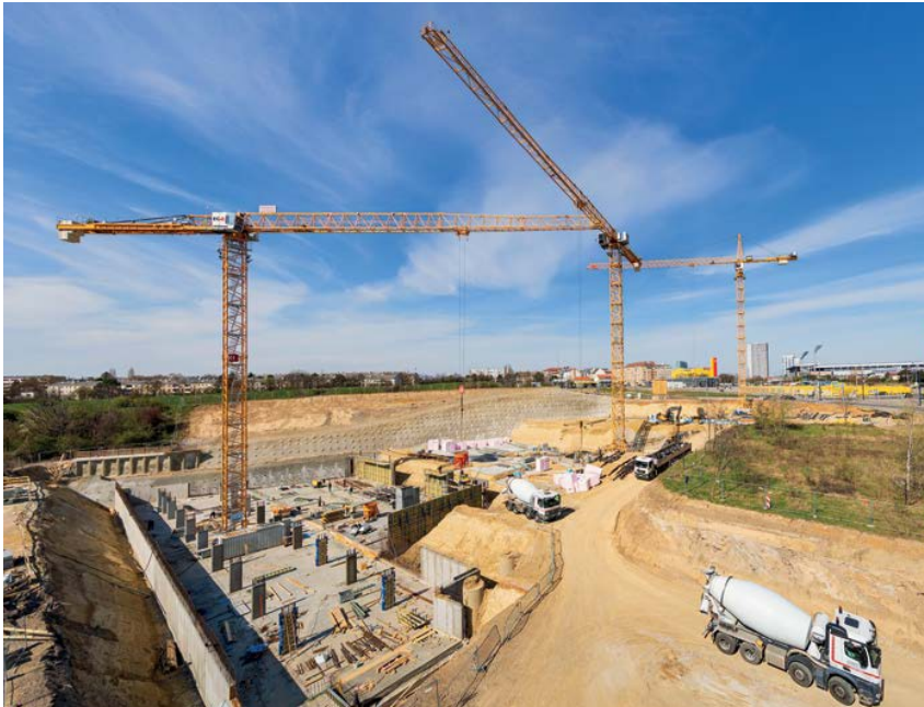
Das House of Science & Engineering der FH Campus Wien ist das erste Projekt in Österreich, das als Allianzvertrag »Hochbau« abgewickelt wird. Schon im Vergabeverfahren hat das deutlich mehr Input der Bieter gebracht.
